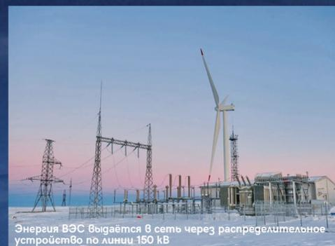
Энергия ВЭС выгаётся в сеть через распределительное устройство по линии 150 кВ
