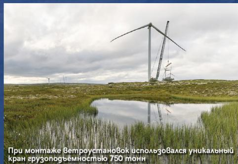
При монтаже ветроустановок использовался уникальный кран грузоподъёмностью 750 тонн
