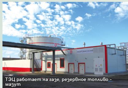
ТЭЦ работает на газе, резервное топливо – мазут
